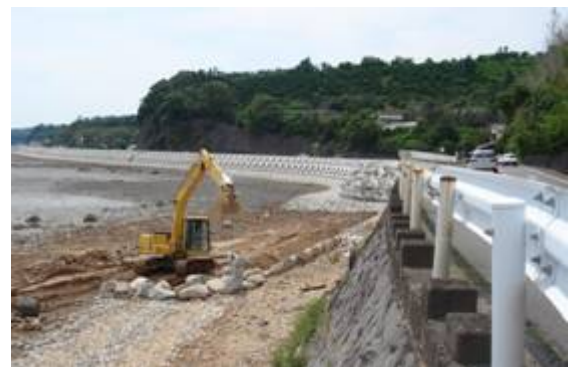
写真-1 高潮災害後の不知火海岸の復旧工事: 防災機能が向上する一方で、沿岸道路の景観や干潟の減少により生物生息場が消失
