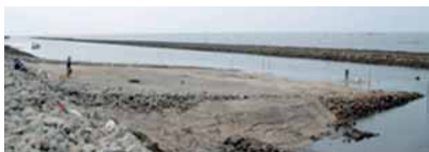
熊本港「北なぎさ線」：多数のアサリ貝やタイラギ等の着床・生残を確認
